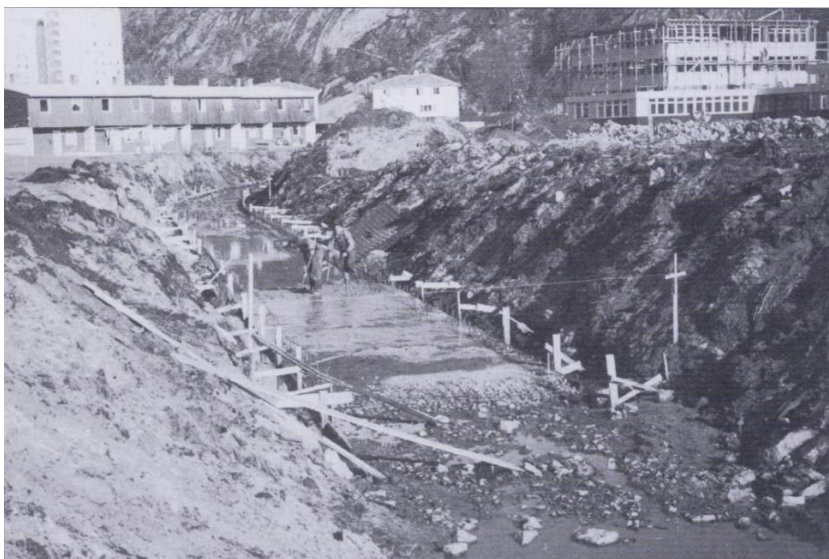
Figur 3 Bygging av Møllelevannskanalen, ovenfor Krossebroen. (Holte, 1992)
