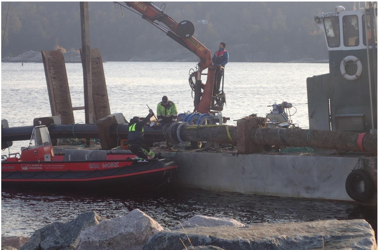
Figur 70 Reparasjon av ledning i sjøen fra Korsvik til Tangen..
