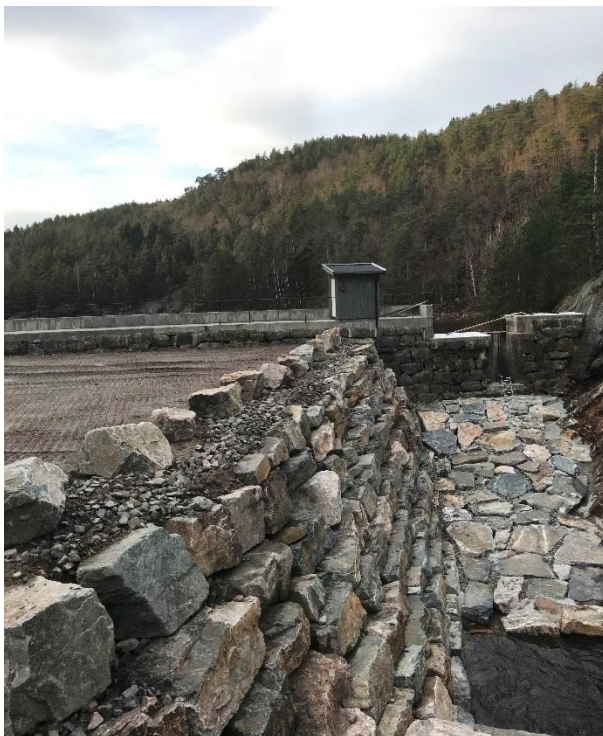
Figur 99 Utbedring av dam ved Grotjønn.
