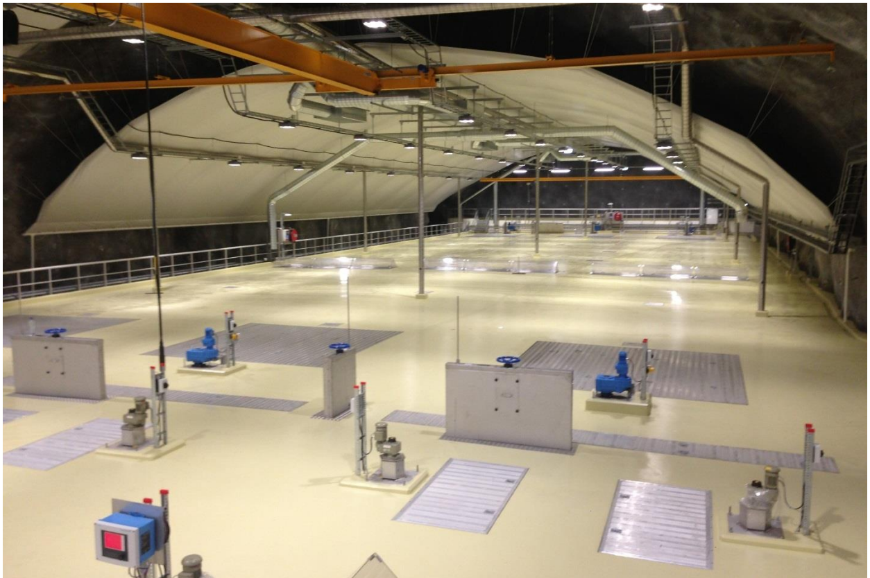
Figur 16 Odderøya rensanlegg – ny sedimenteringshall.
