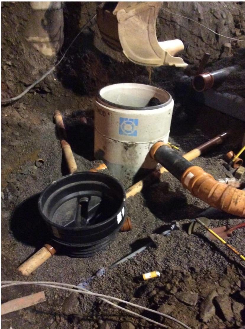
Figur 93 Utskifting av kumgruppe i Hånesveien.
