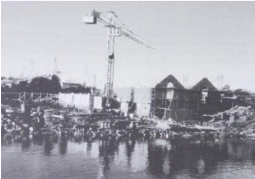
Figur 4 Bredalsholmen renseanlegg under bygging i 1989. (Holte, 1992)
