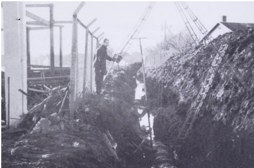
Figur 2 Legging av 24" avløpsledning på Tangen januar 1957. (Holte, 1992)
