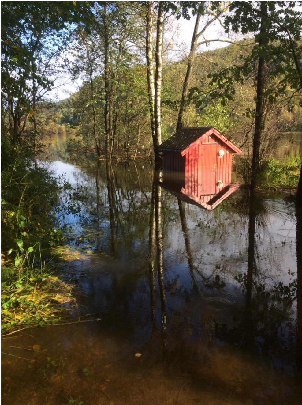
Figur 94 Kallebrotet pumpestasjon i oktober 2017.
