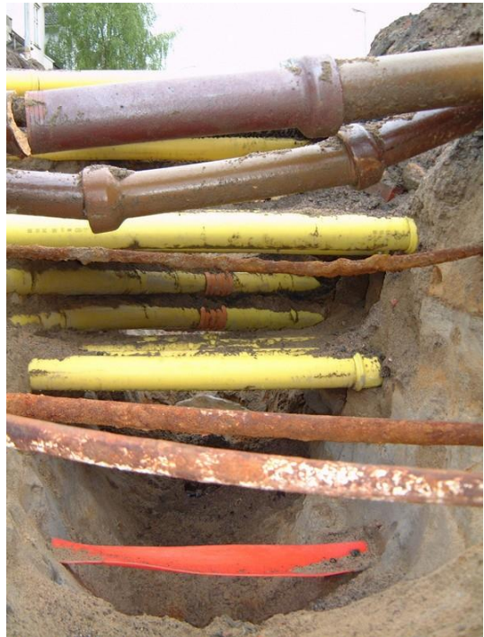
Figur 90 Hva som er i bakken – graving i Tordenskjoldsgate.
