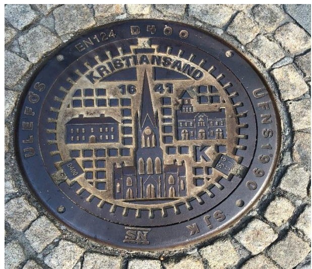
Figur 18 Ledningsanlegget er skjult, men kumløkkene er godt synlig.
