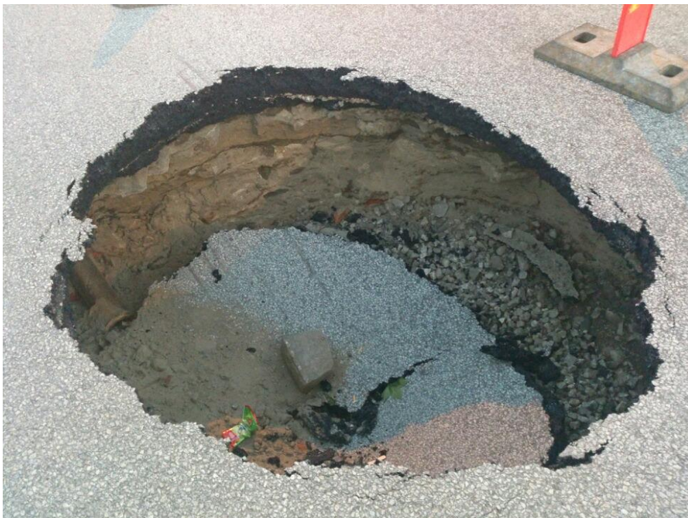
Figur 91 Synkehull i Vestre Strandgate.
